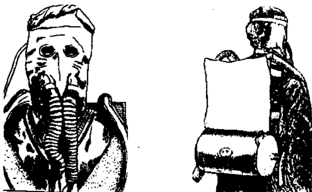
Рис. 24. Первый автономный кислородный аппарат Г.Флюсса: Л — вид спереди; Б — вид сзади
